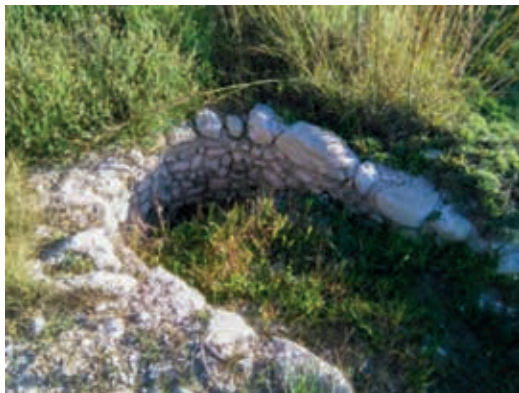
Restos de la lumbrera soterrada y minado.
