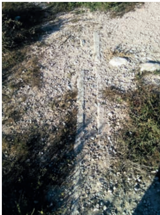
Restos todavía visibles de la acequia de Santa Bárbara, próxima al acueducto de la rambla de Pusa, que llevaba el agua a las fuentes de la villa de Eda.
