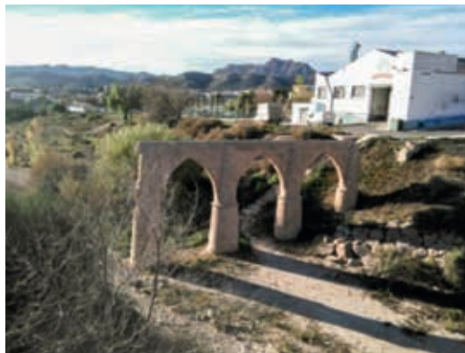
Acueducto de la rambla de Pusa, parte superviviente a la riada de 1884
