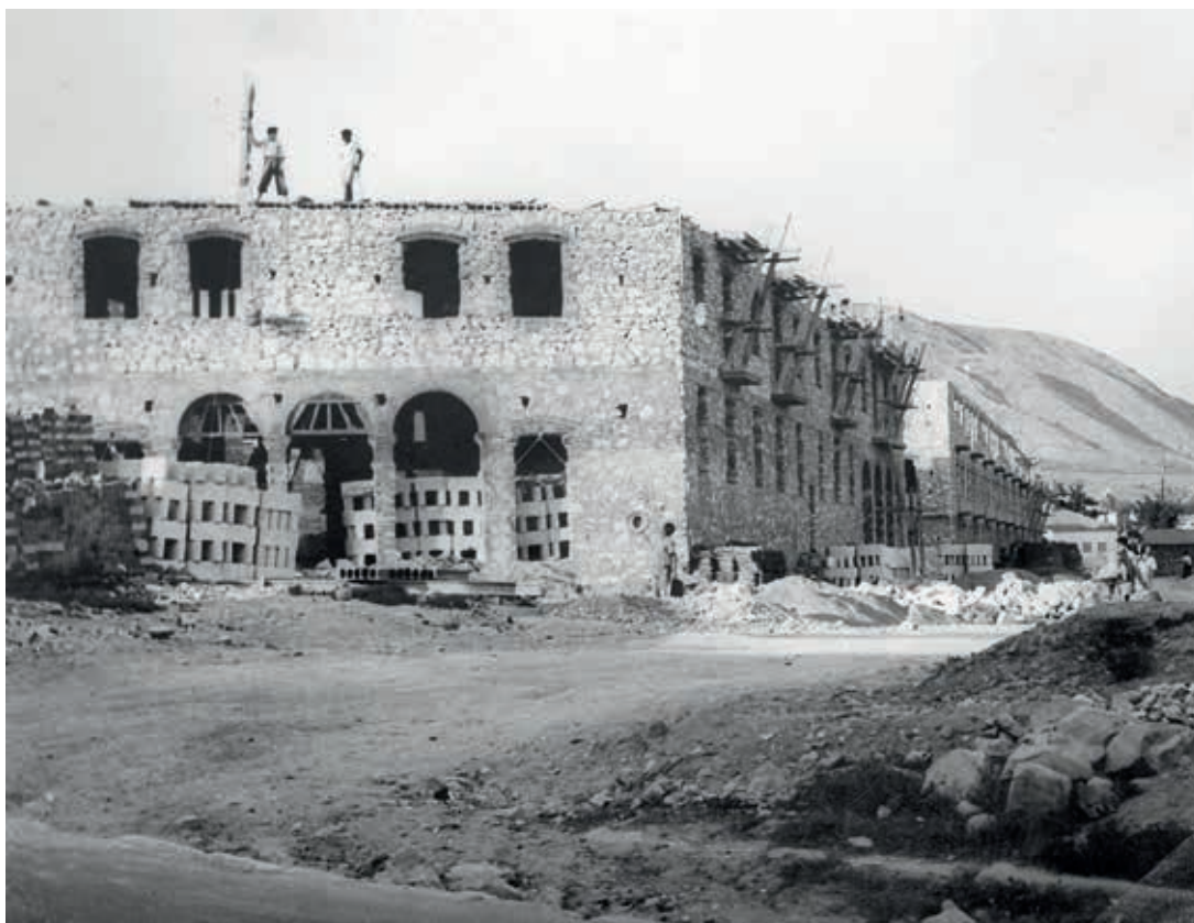
Detalle de la construcción del barrio Virgen de la Cabeza (finales de los años 50). Fuente: Alborada, 36, 1990, 94.
