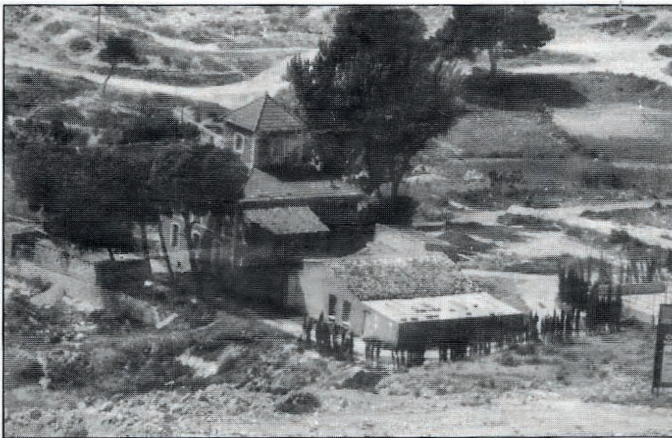
Vista de la Casa Colorá, antes de su reforma
